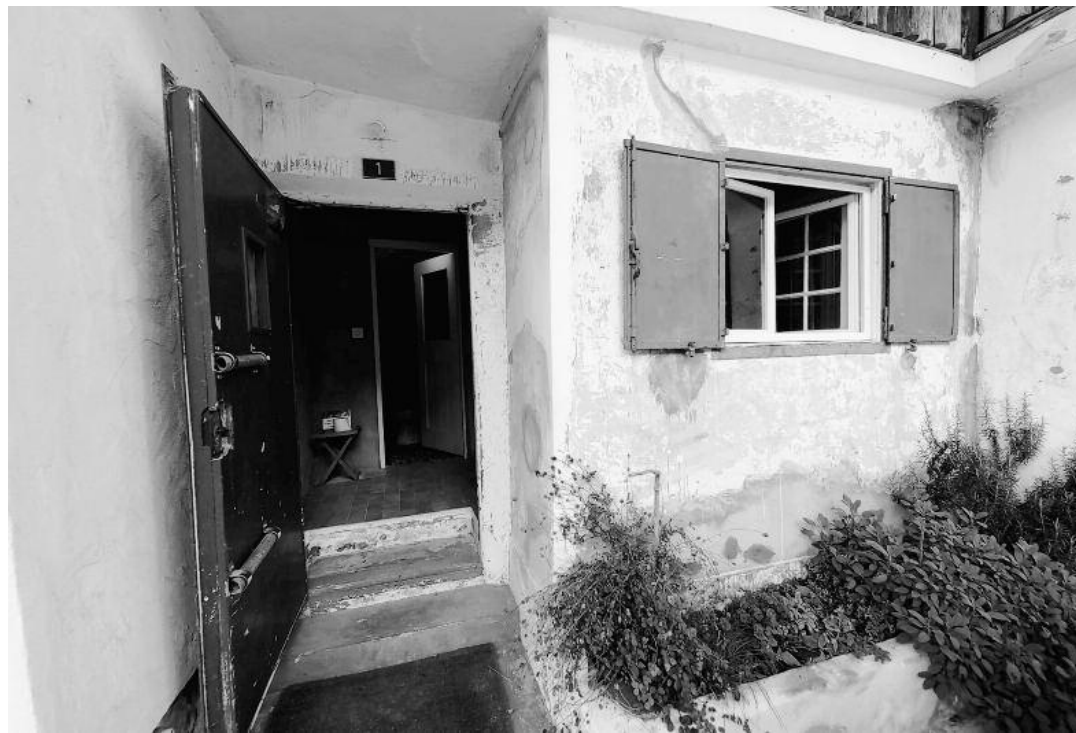
Der Eingang zum Felsenhaus.
